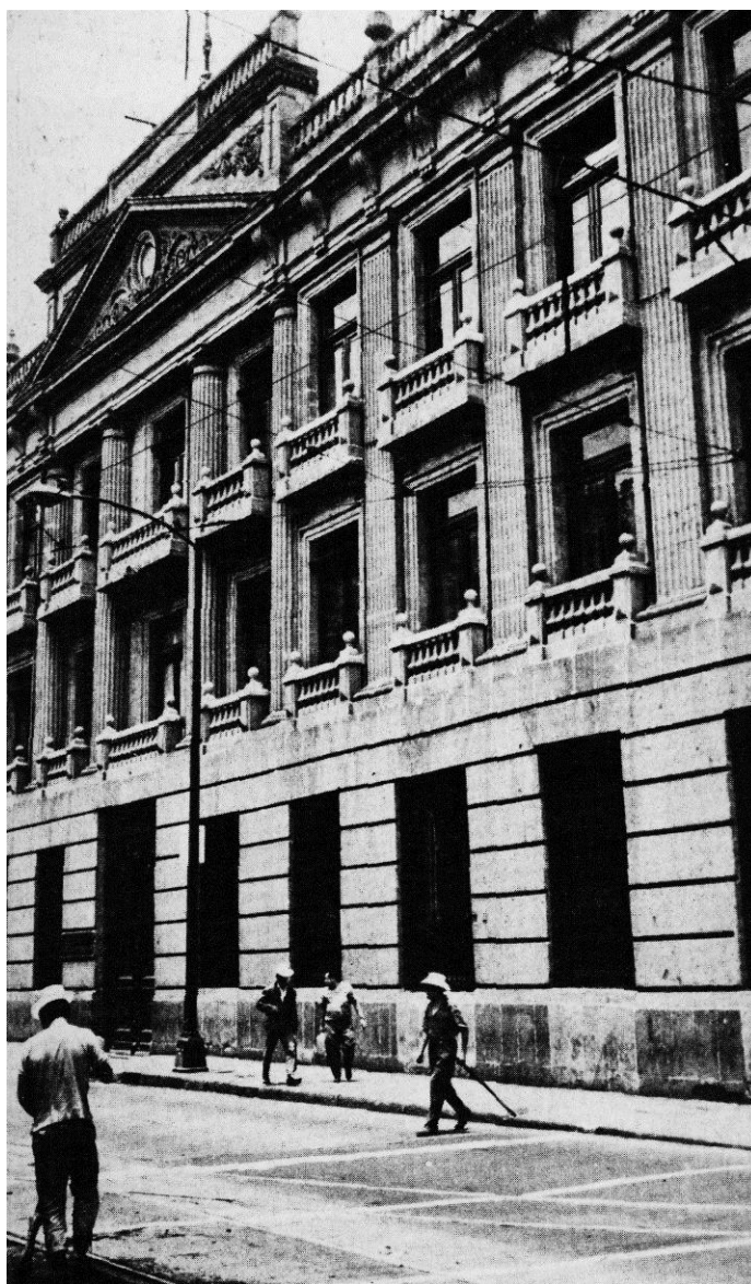
Secretaría de Educación Pública en la calle de Argentina; fachada. Distrito Federal
