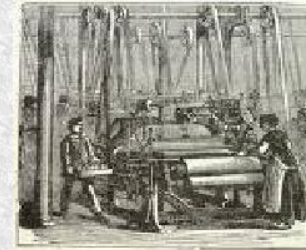
Fig. 95. — Intérieur d'une filature.
